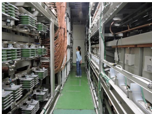
国内最大の蓄電エネルギーを有するコンデンサーバンク
